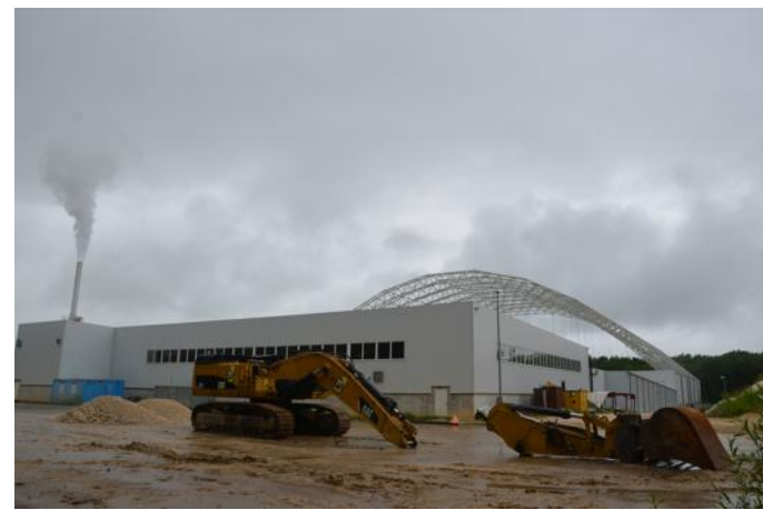
N.L. Vue arrière de la grande halle d'excavation.
