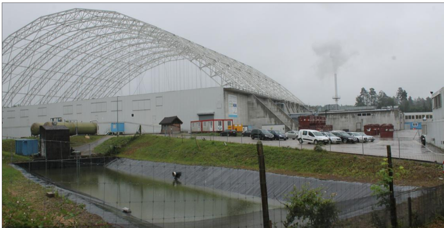
Le site de Bonfol où se déroulent les travaux.
