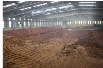
Fig. 2.3 Exemple halle Trihalde – Env. 25'000 m 3 /h d'air sont déplacés pour une dépression de 30 Pa
